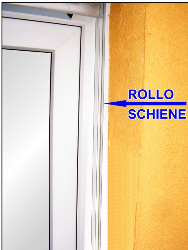
Das Leibungsdämmprofil wird auf der Rolloführungsschiene oder direkt auf dem Fensterrahmen gesetzt und erstellt so eine Rahmenverbreiterung
